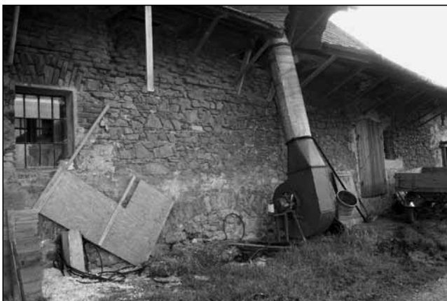
Západní průčelí hospodářské části s kamennými pasy, foto 2009.
