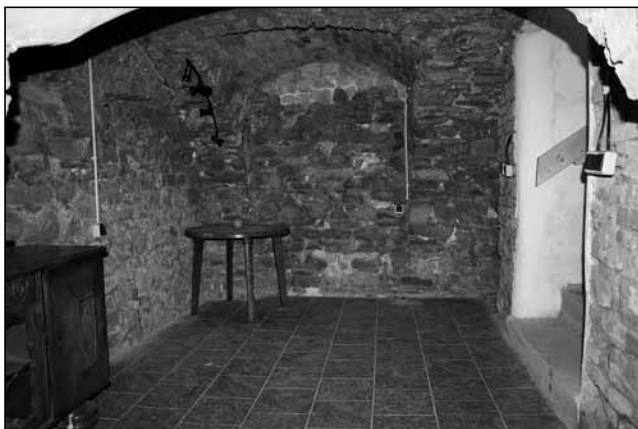
Východní strana suterénní místnosti s cihlovou zadržkou historického sestupu do suterénu, foto 2009.
