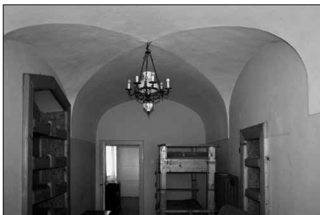
Místnost v jihovýchodním nároží s klenbou se styčnými výsečemi, patrně komora, foto 2009.
