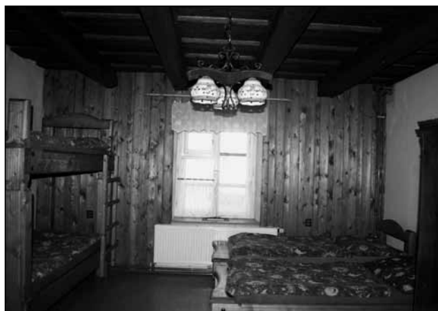
Obytný pokoj s trámovým stropem datovaným po roce 1852, foto 2009.
